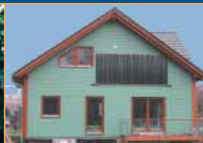
Eengezinswoning met gevelopbouw
